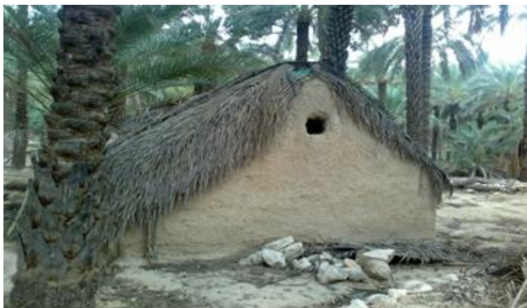
شکل ۱۳. نمونه‌ای از کاربرد برگ در سقف خانه، روستای قعله کهنه (منبع: نگارنده)
