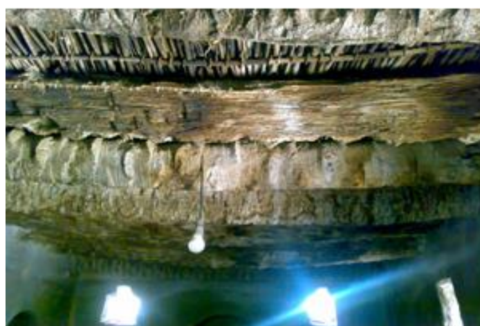
شکل ۲۱. نمونه از کاربرد تنه درخت خرما در سقف، روستای قلعه کهنه (منبع: نگارنده)
